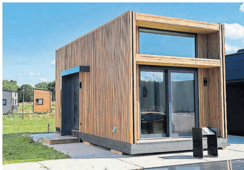
Een proefwoning van Nedpanel in Almere. FOTO NEDPANEL
